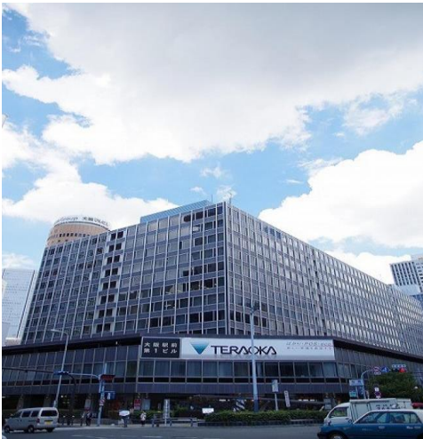
「大阪駅前第一ビルの外観」 「Osaka Ekimae Daiichi Bld」
